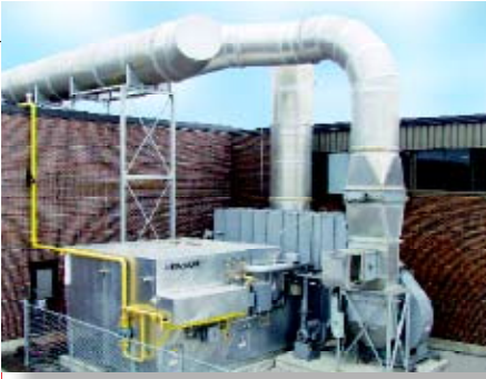
MAGNUM 循环催化氧化器提供最低CO和NOx排放的可靠性能。
