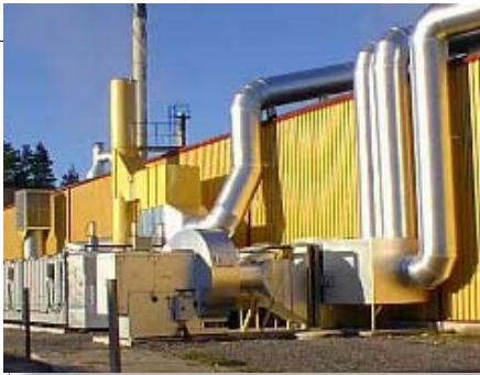
VOCSIDIZER RTO适于柔性版印刷工艺中的VOC排放和气味去除
