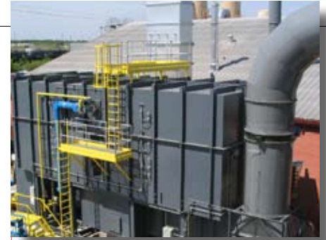
CLEANSWITCH RTO设备适于软包装工厂的VOC处理
