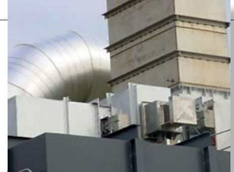
二级热回收系统将能量用于制程/工艺处理以及用热单位
